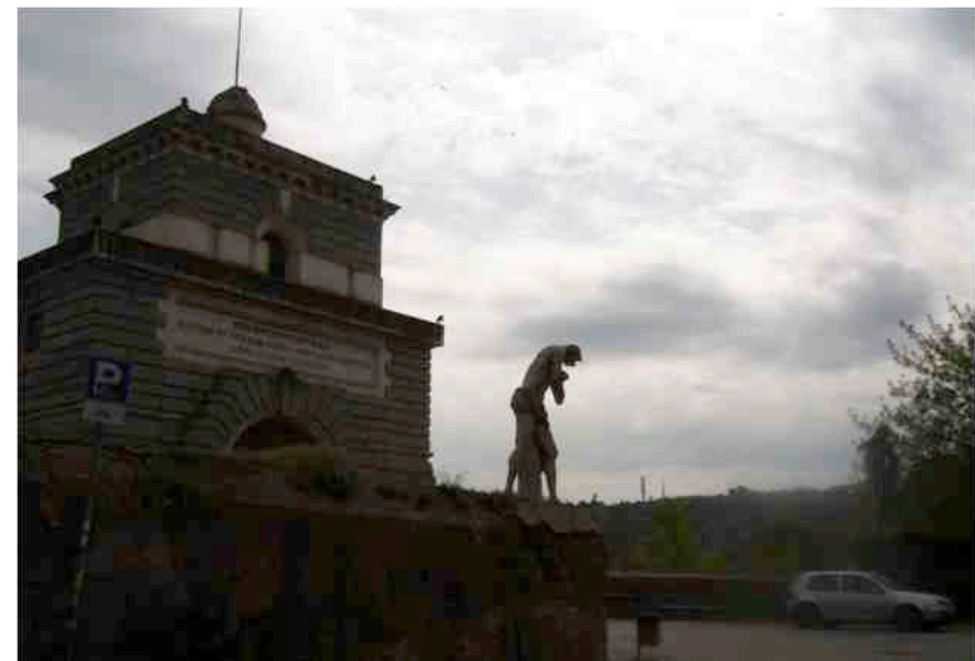
Figure 2.33 Ponte Milvio (Montejo, 2009).
