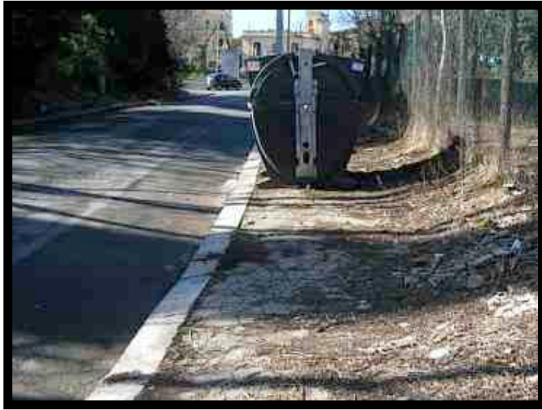
Retrofitted sidewalk on Via dei Pisoni
